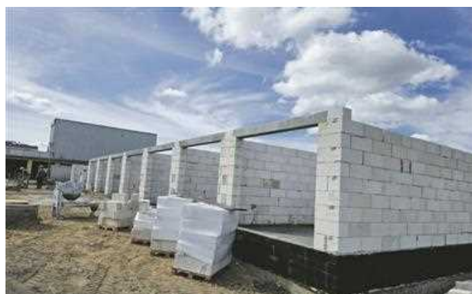
Budowa garaży - stan na 02.08.2024r.
