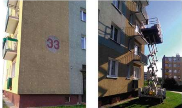
Remont balkonów w os. Kopernika 33
