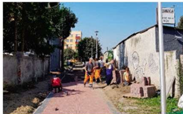
Remont chodnika w os. 60-lecia (od ul. Lubichowskiej do MPP nr 10)
