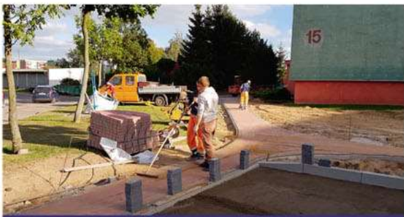
Wykonanie chodnika przed budynkiem ul. Juranda ze Spychowa 15
