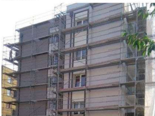
Docieplenie budynku Alei Wojska Polskiego 10 styropianem, gr. 100 mm przy wraz z remontem balkonów, rynien i obróbek blacharskich.
